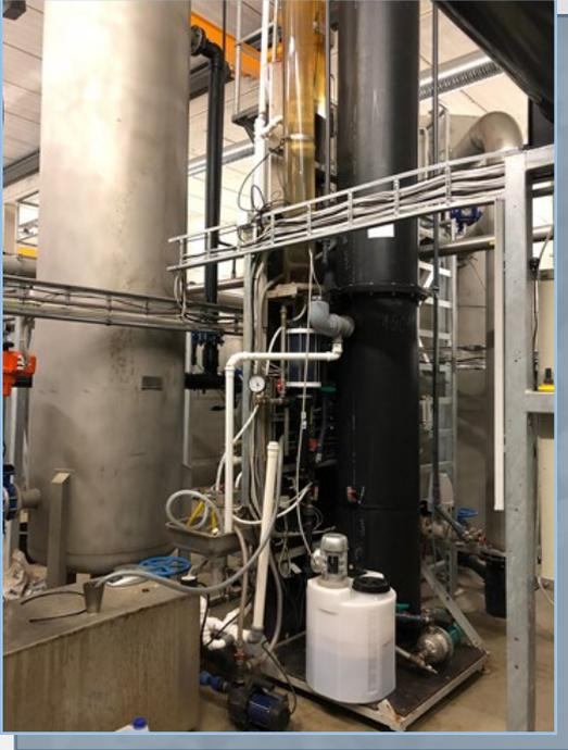
La planta piloto ya está **instalada y en marcha** en la planta de tratamiento de aguas de **Viimsi** (Estonia). Dicha planta ha sido diseñada para la **eliminación** de **Ra-226, Ra-228** y otros contaminantes del agua, principalmente.
